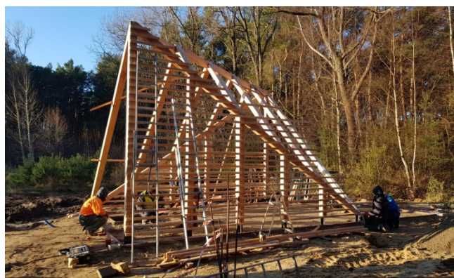
Fot. 4. Wiata rowerowa w Mrzeżynie na etapie budowy.
