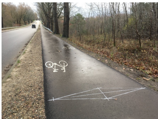
Fot. 12-15. Montaż czujników do pomiaru ruchu rowerowego w Rogowie, Kmiecinie i Władysławowie
