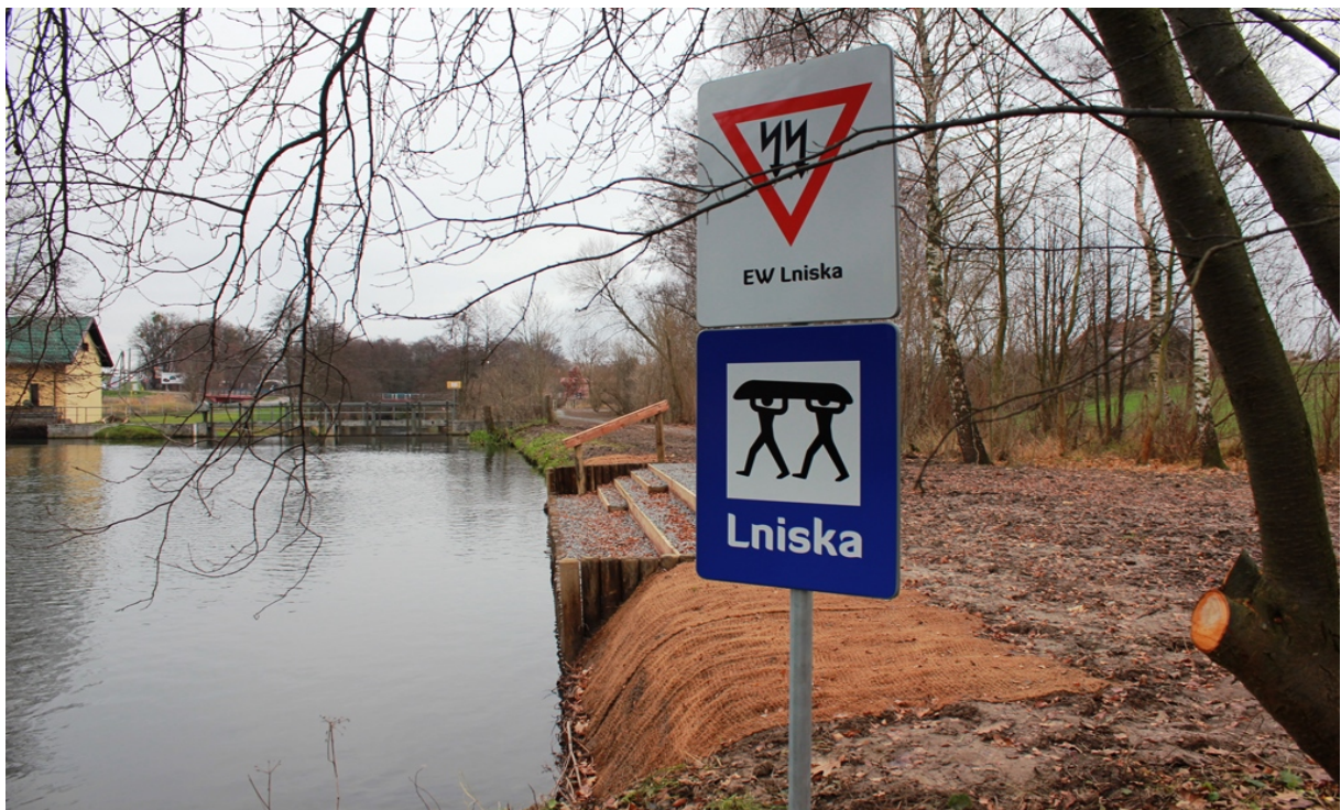
Przykładowe wykonanie znaku wodnego na konstrukcji stalowej dla potrzeb realizacji przedsięwzięcia Pomorskie Szlaki Kajakowe
