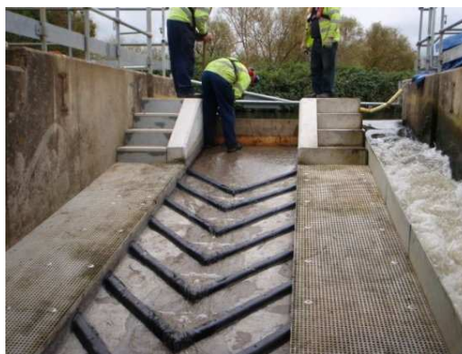
(fot.59,60) Przykładowe rozwiązanie pokonania bariery na rzece z jednoczesnym utworzeniem przepustu dla ryb i węgorzy.
