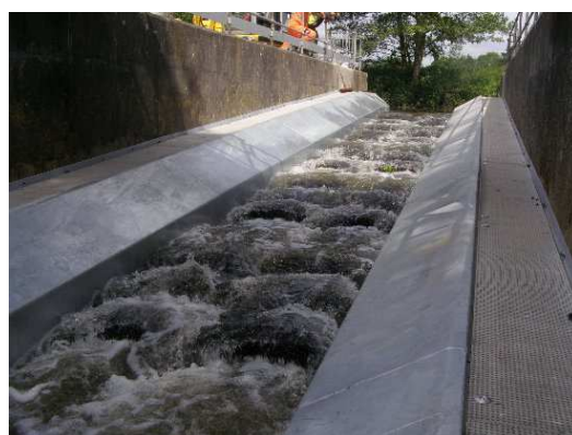
(fot.56,57) Przykładowe rozwiązanie pokonania bariery na rzece z jednoczesnym utworzeniem przepustu dla ryb
