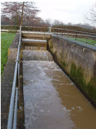
(fot.55) Zdjęcie stanu przed przebudową
