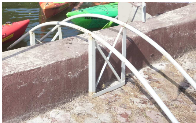
Fot.33. Przykład rozwiązania w terenie – rury stalowe umożliwiają przeniesienie kajaka nad przeszkodą
