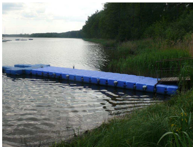
Fot.28. Przykład pomostu pływającego z modułowych elementów z tworzyw sztucznych
