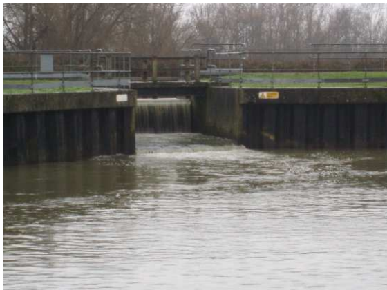
(fot.58) Zdjęcie stanu przed przebudową
