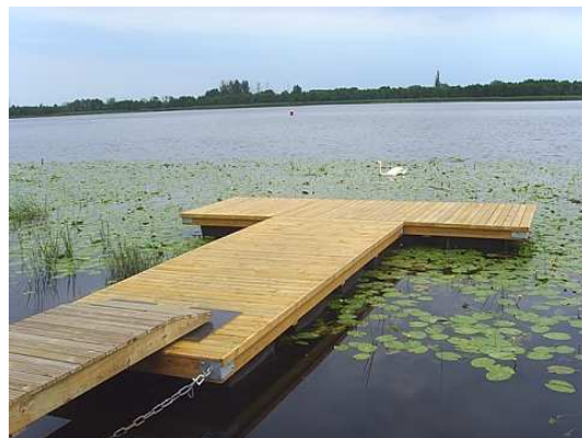
Fot.23. Przykład pomostu pływającego z pokładem drewnianym na pływakach z tworzyw sztucznych
