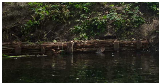
(fot.35) Umocnienia faszynowe
