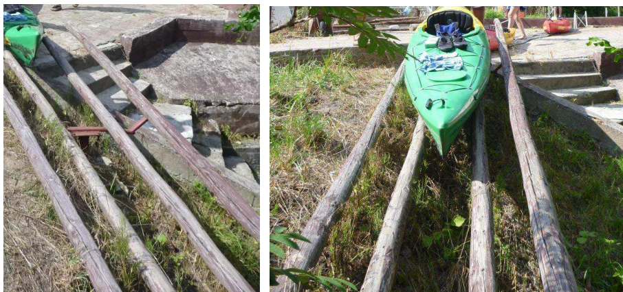
Fot.31.32. Przykłady rozwiązania w terenie - żerdzie drewniane nie podparte palikami – w przypadku podniesienia ich na wysokość j.w będzie możliwe przesuwanie kajaka w sposób wygodniejszy dla kajakarza
