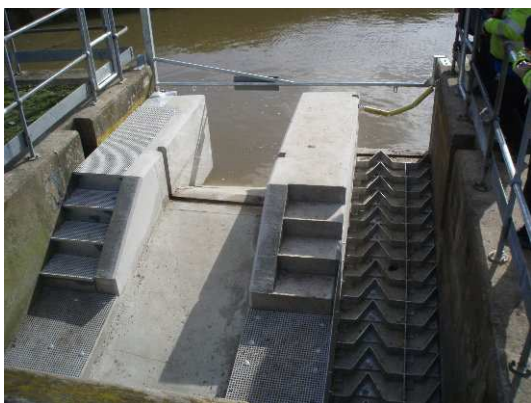
(fot.59,60) Przykładowe rozwiązanie pokonania bariery na rzece z jednoczesnym utworzeniem przepustu dla ryb i węgorzy.
