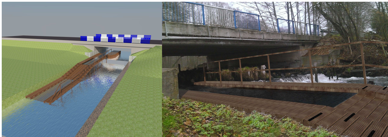
(fot.52/wiz.) rz. Chocina, Chociński Młyn – przejście pod 1 przęsłem mostu
