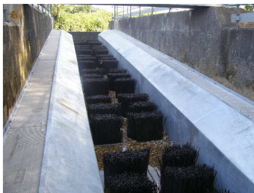
(fot.56,57) Przykładowe rozwiązanie pokonania bariery na rzece z jednoczesnym utworzeniem przepustu dla ryb
