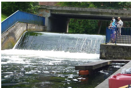
(fot.45) Przykład realizacji - Łyna
