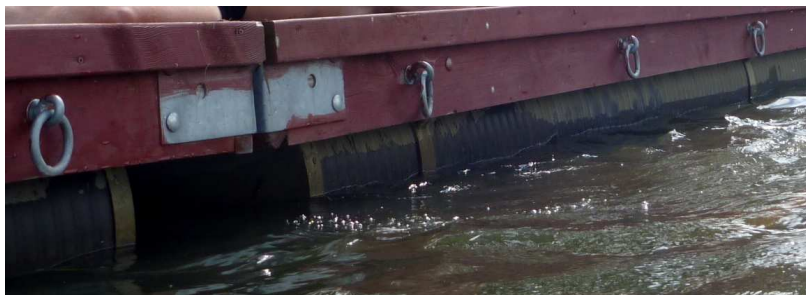
Fot.22. Przeplotka w postaci obręczy – mocowanie od czoła podłużnej części pomostu
