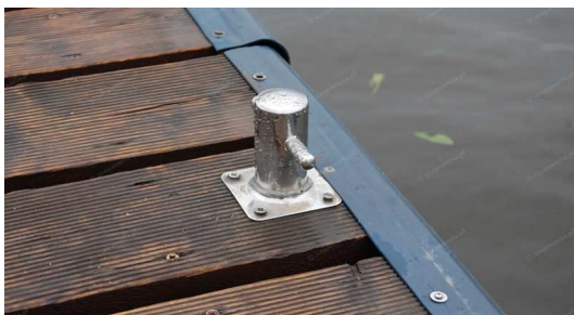
Fot.20.21. Knaga, pachołek – mocowanie do górnej części pokładu
