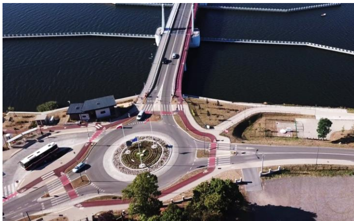
Fotografia 11. Przykład rozwiązania ruchu rowerowego w obrębie dużego ronda i powiązania go z obiektem mostowym, Gdańsk Sobieszewo Źródło: Materiały Urzędu Marszałkowskiego Woj. Pomorskiego
