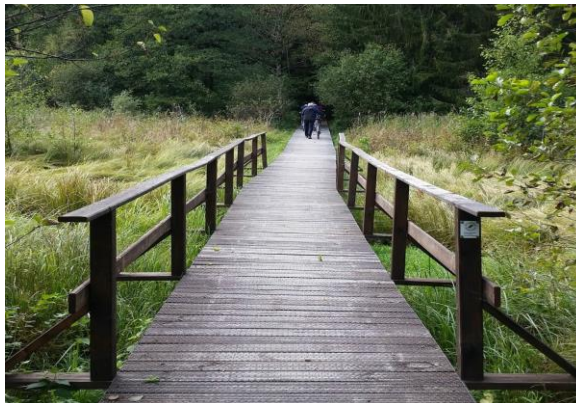
Fotografia 18. Kładka drewniana, uszorstniona siatką stalową o drobnych oczkach, Wigierski Park Narodowy.
