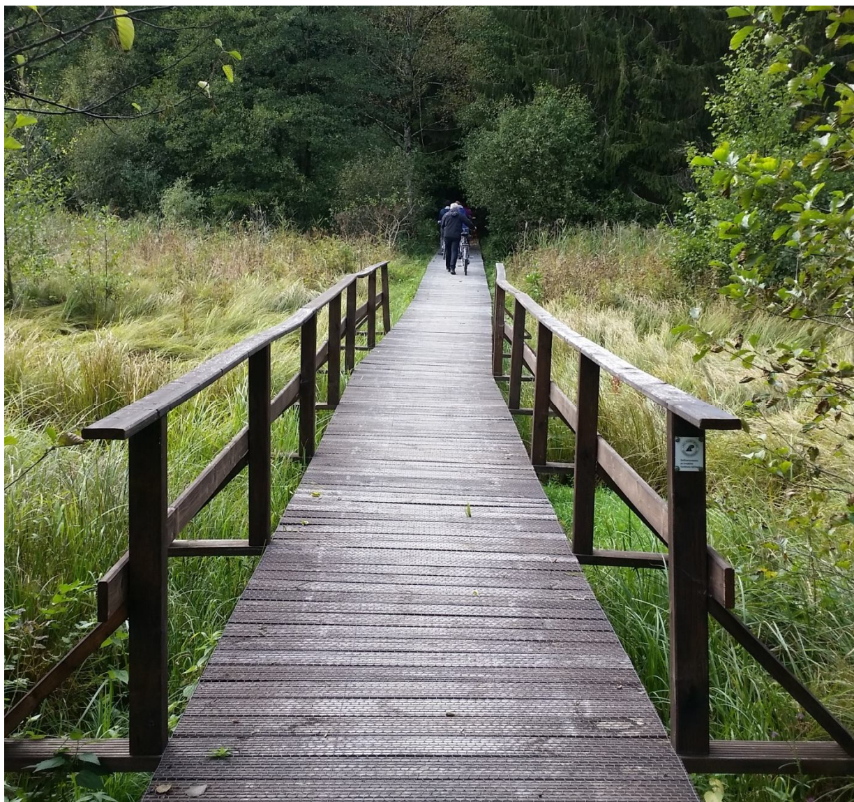
Fot. 5. Kładka drewniana, uszorstniona siatką stalową o drobnych oczkach, Wigierski Park Narodowy Źródło: archiwum Vision MC, Jacek Zdrojewski
