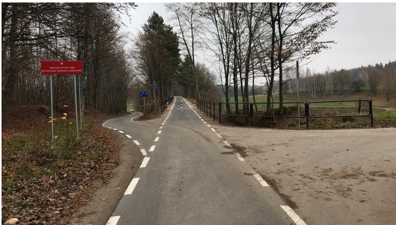
Fot. 10. Trasa rowerowa po dawnej linii kolejowej, Bytów
