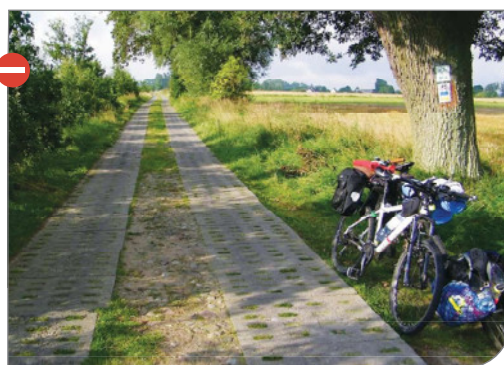
Nawierzchnia z płyt betonowych o niskim komfortie jazdy, Powiat wejherowski, fot. T. Milewski
