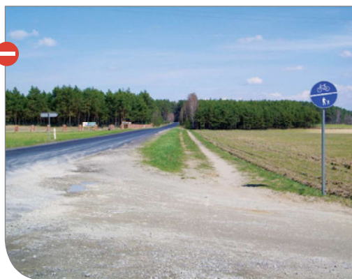
Nieutwardzony ciąg pieszo-rowerowy, Brody, Droga wojewódzka nr 237 Czersk-Tuchoła, fot. T. Milewski
