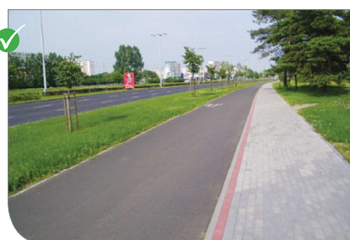
Odpowiednio separowany i wykonany ciąg pieszo-rowerowy, Toruń, fot. T. Milewski
