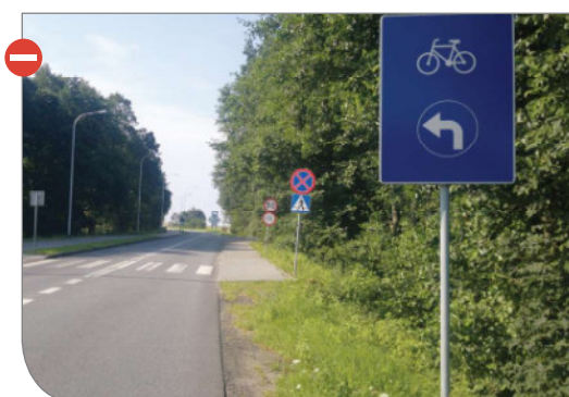
Brak prawidłowo wykonanego wjazdu na drogę dla rowerów, segregacja ruchu dyskryminująca rowerzystów (konieczność korzystania z drogi o gorszej nawierzchni). Okolice Bytowa, fot. Jacek Zdrojewski.
