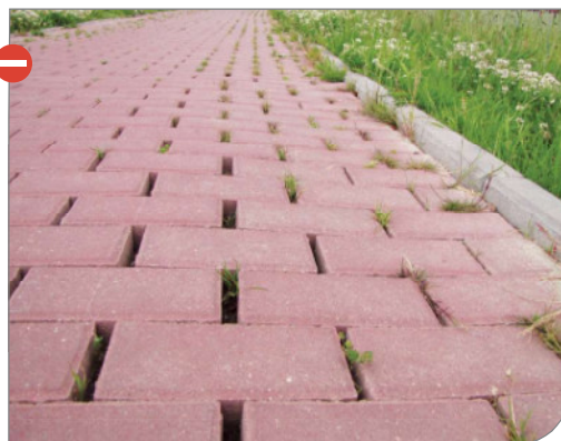
Nawierzchnia typu „polbruk” na terenie niezabudowanym – widoczne zarastanie przez roślinność oraz zapadnięcia, zmniejszające dodatkowo komfort jazdy. Okolice Nowego Dworu Gdańskiego, fot. J. Zdrojewski
