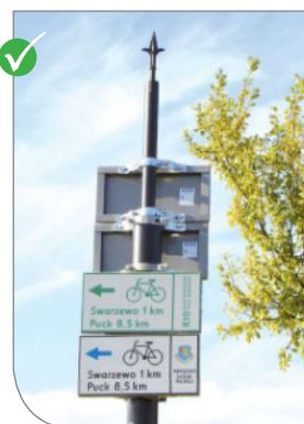
Ozdobny słup metalowy z umieszczonymi na nim tabliczkami R3 we właściwej hierarchii (najpierw szlak międzynarodowy, potem krajowy). Okolice Pucka, fot. TREK, Marcin Szydąg
