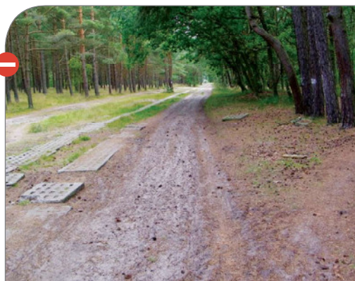
Droga leśna o nawierzchni nieutwardzonej (piaszczystej, ze zniszczonymi płytami IOMB) rozjeżdżana po bokach przez rowerzystów. Szlak R10 Jarosławiec-Dartowo, fot. T. Milewski
