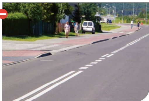
Nieprawidłowo zaprojektowany ciąg rowerowy – „fale Dunaju”, brak skrajni, priorytet dla zjazdów indywidualnych na posesje. Rumia, fot. T. Milewski
