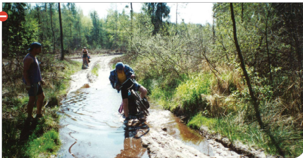
Nieprawidłowe odwodnienie nawierzchni szlaku. Beskidy, fot. M. Mąkosa
