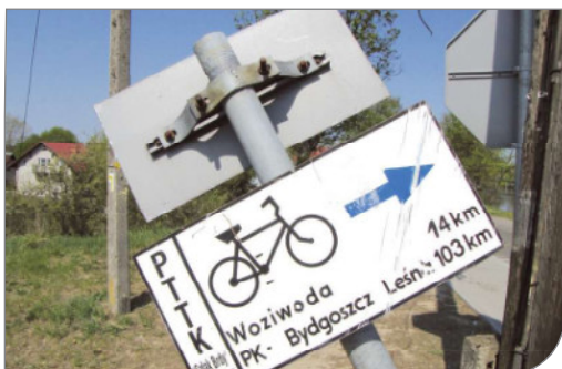
Uszkodzony przez samochód znak i słupek typu R3, Męcikał. fot. TREK, Jacek Zdrojewski
