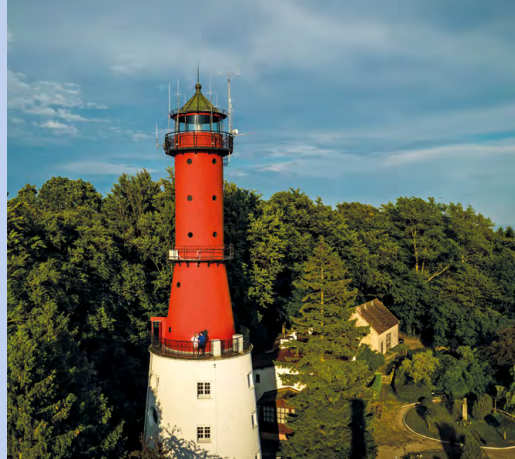
Latarnia morska w Rozewiu
