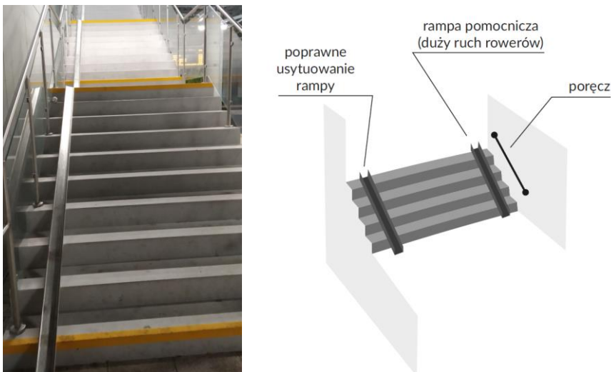
Fotografia 5., Rysunek 21. Poprawne zainstalowanie rampy rowerowej. Źródło: Materiały Urzędu Marszałkowskiego Woj. Pomorskiego oraz opracowanie własne.
