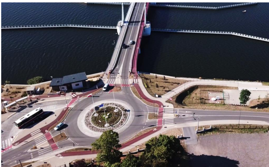
Fotografia 11. Przykład rozwiązania ruchu rowerowego w obrębie dużego ronda i powiązania go z obiektem mostowym, Gdańsk Sobieszewo Źródło: Materiały Urzędu Marszałkowskiego Woj. Pomorskiego
