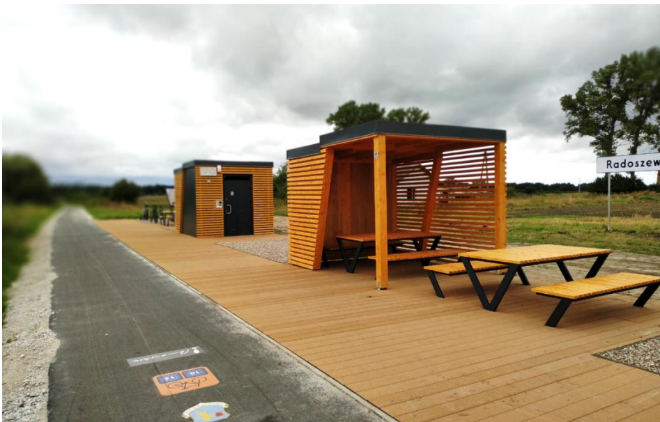
Fotografia 27. Radoszewo EV10/13, miejsce postojowe, Gm. Puck. Wyposażenie: toaleta, wiata, ławostoly, stojaki rowerowe, dostęp do bieżącej wody
