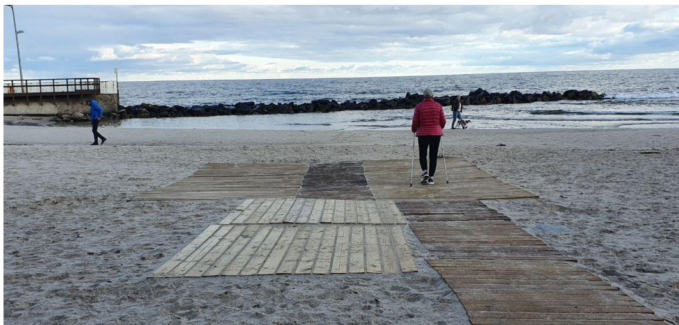
Fot. 09. Niepołączone ze sobą elementy ciągów pieszych mogą utrudniać poruszanie się wózkiem. Styk poszczególnych elementów należy rozwiązywać ze szczelinami nieprzekraczającymi 20 mm (optymalnie do 10 mm)
