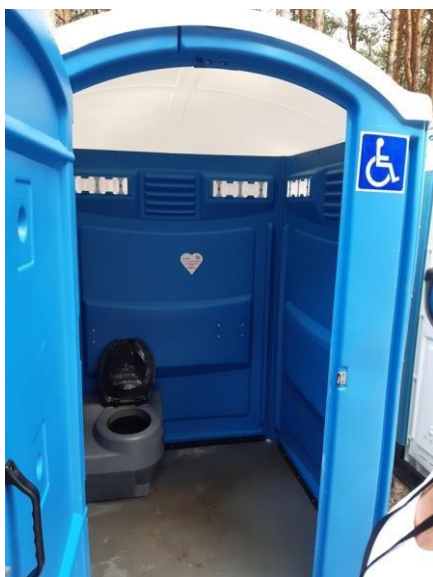
Fot. 35. Toaleta przenośna dla osób z niepełnosprawnościami
