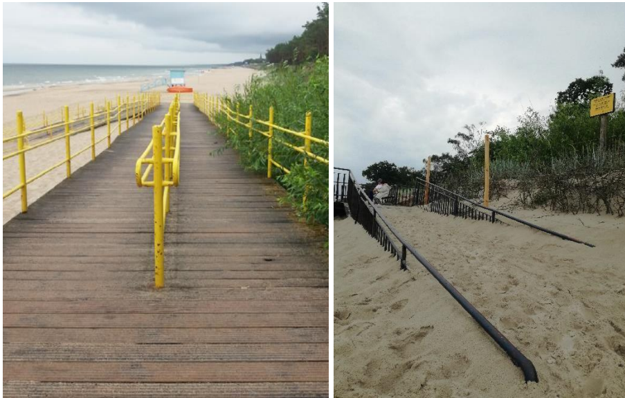
Fot. 13. Pochylnia z nawierzchnią drewnianą (po lewej)
