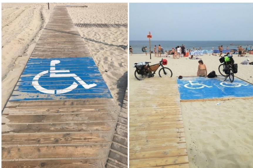
Fot. 10-11. Niepotrzebne oznaczenia ciągów drewnianych (nie należy takich stosować – mogą być odbierane jako stygmatyzujące)
