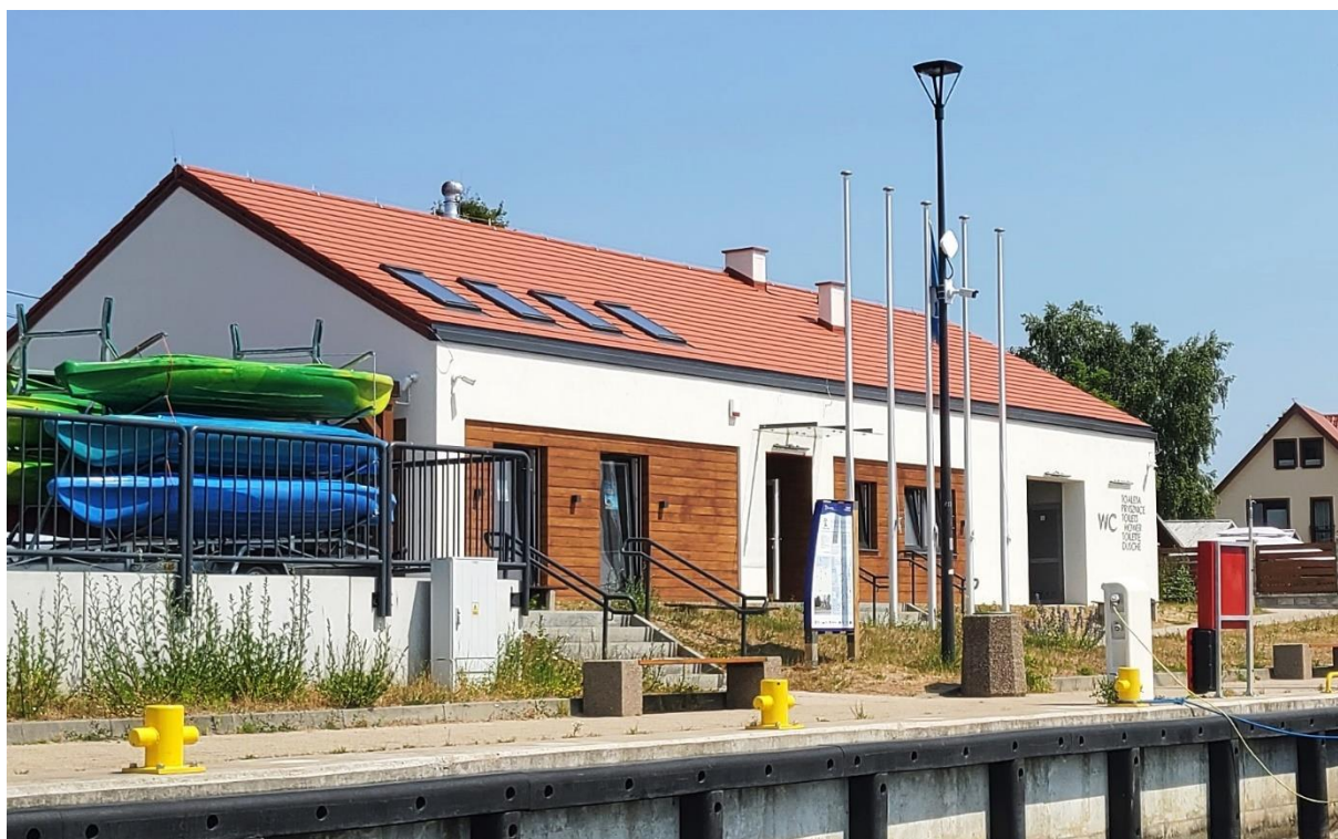
Fot.72. Przykładowy budynek bosmanatu z sanitariatami i zapleczem technicznym; źródło: archiwum własne
