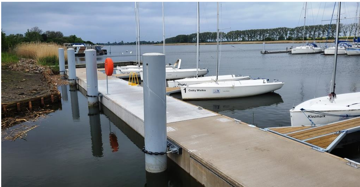
Fot.15. Pomost pływający żelbetowy; źródło: archiwum własne
