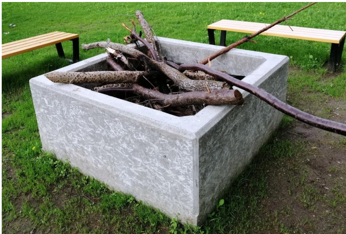
Fot.62. Palenisko formie monolitu betonowego; archiwum własne
