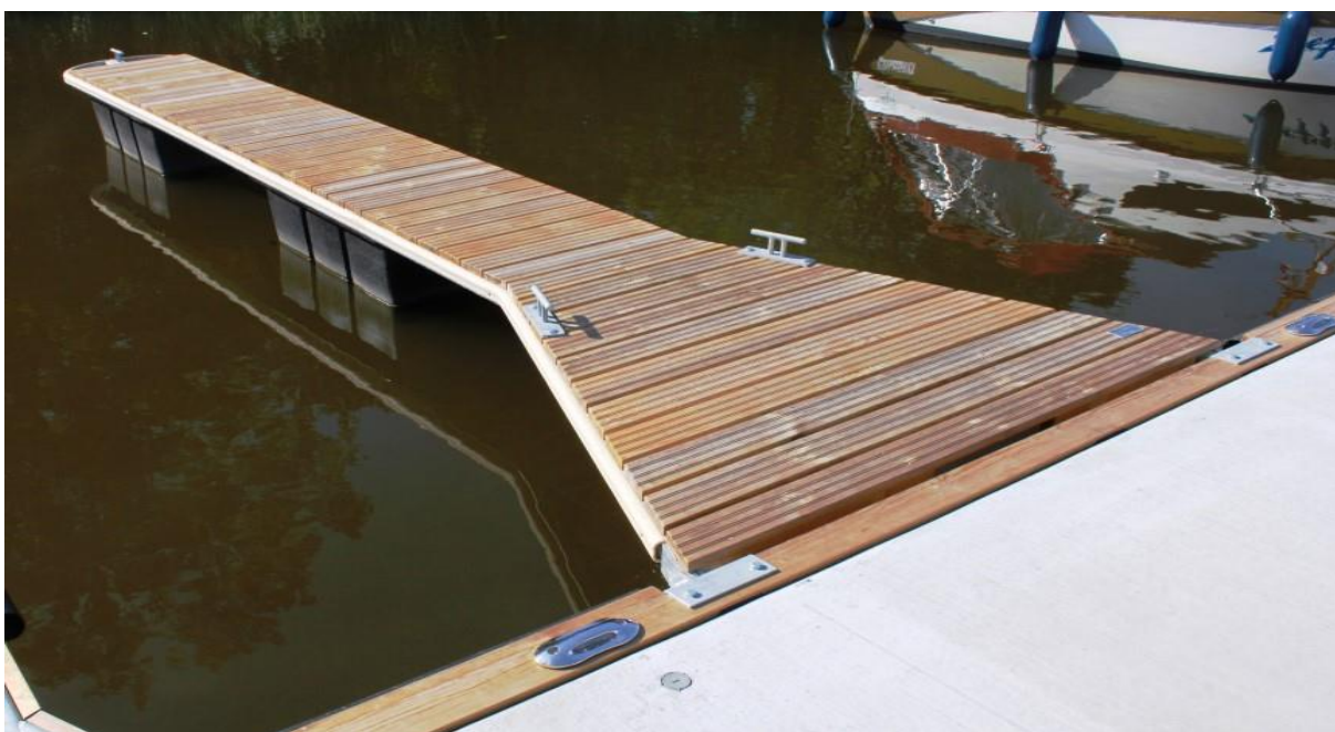
Fot. 18. Dystansowa odnoga z pływakami z tworzyw sztucznych z kładką; źródło: archiwum własne
