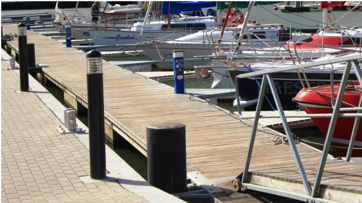
Fot.14. Pomost pływający wykonany z pływaków betonowych o poszyciu drewnianym; źródło: archiwum własne
