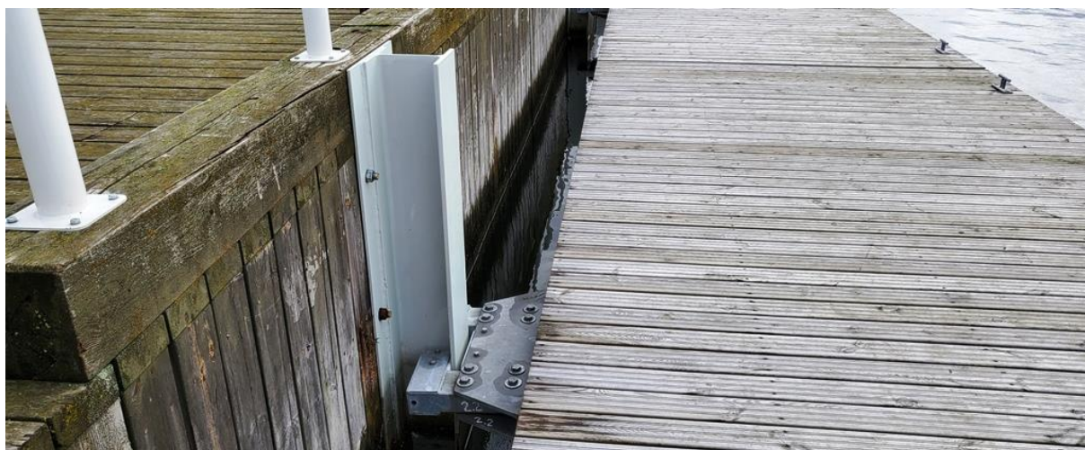
Fot.22. Kotwiczenie pomostu za pomocą suwaków; źródło: archiwum własne
