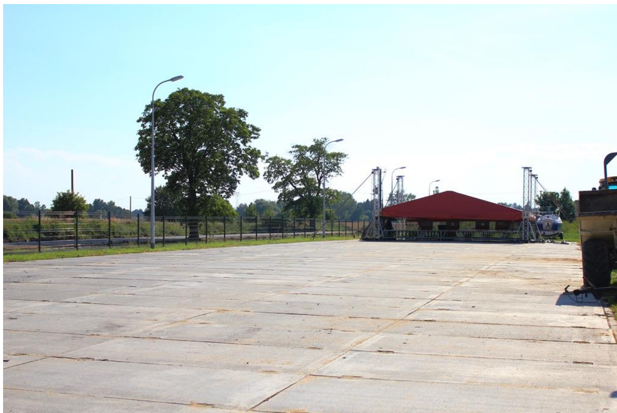
Fot.57. Plac do zimowania jachtów na bazie płyt betonowych; źródło: archiwum własne
