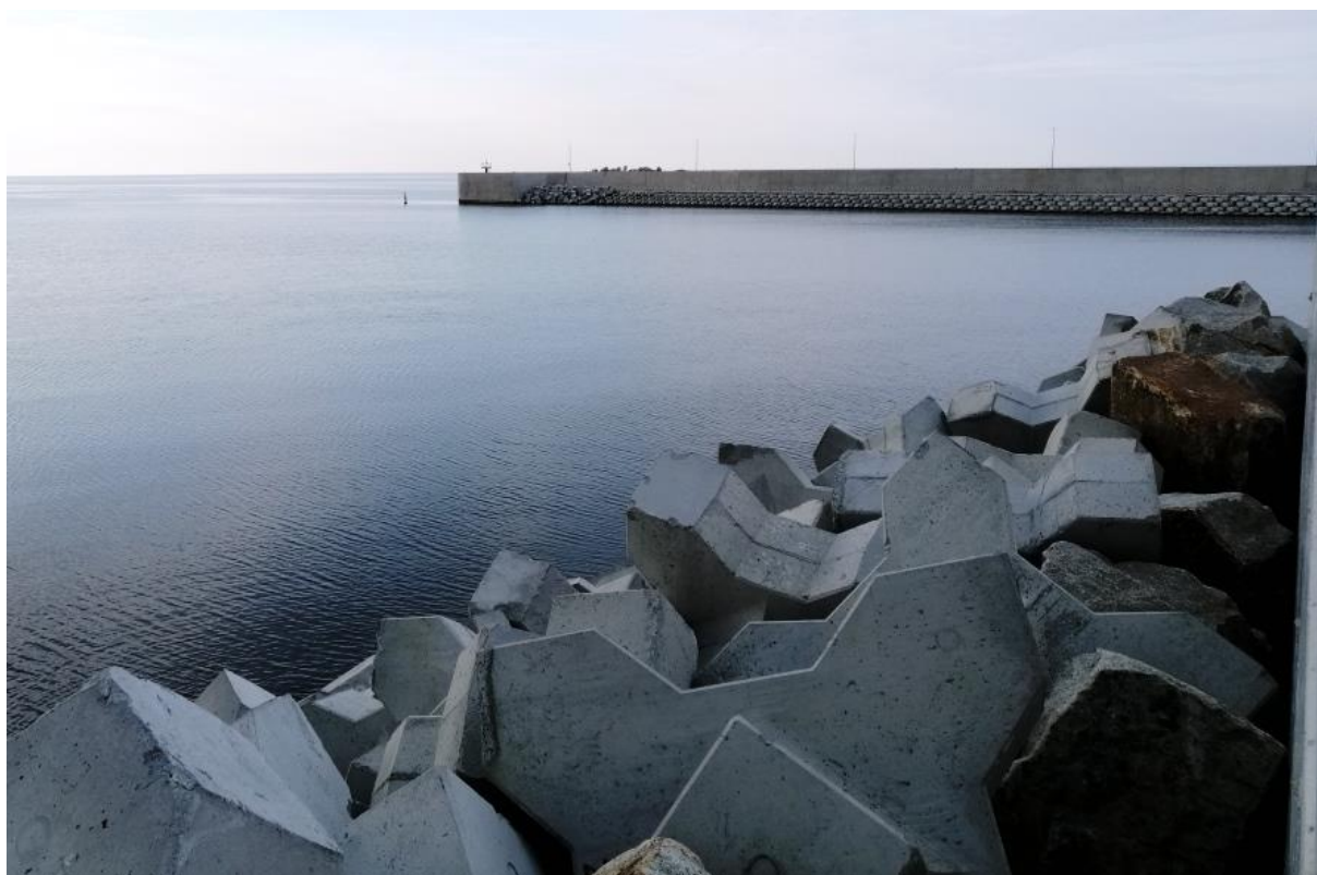
Fot.4. Falochron o ścianach stromych z narzutem bloków betonowych (X-bloki); źródło: archiwum własne.
