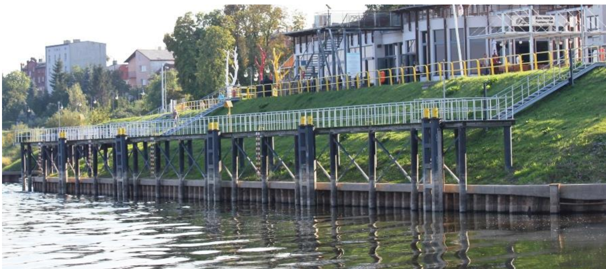
Fot.11. Pomost stały o konstrukcji stalowej; źródło: archiwum własne
