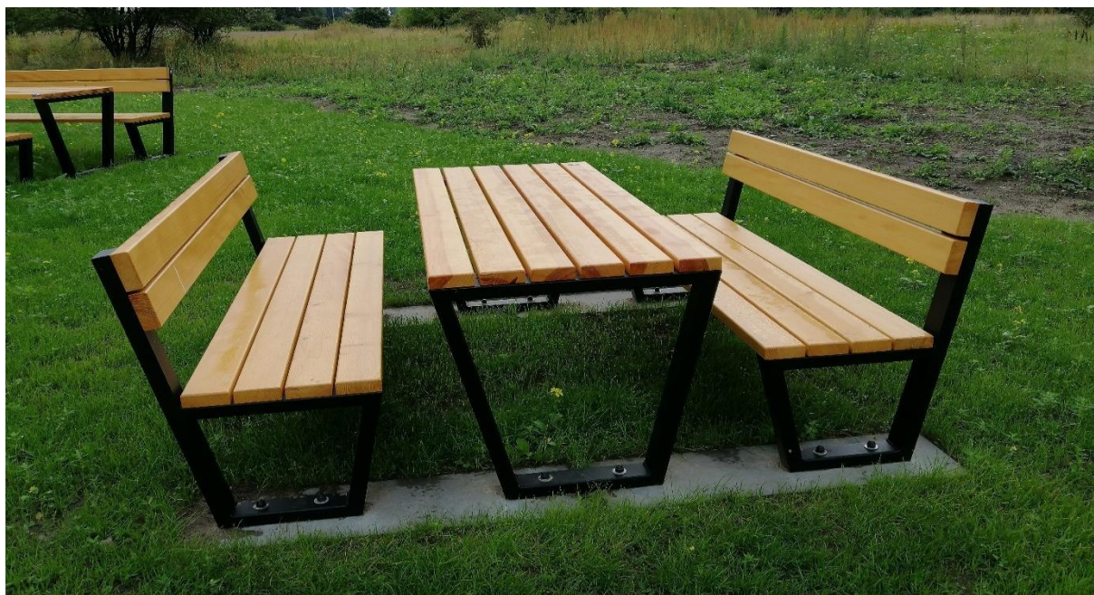
Fot.61. Ławostół kotwiony do podłoża; archiwum własne
