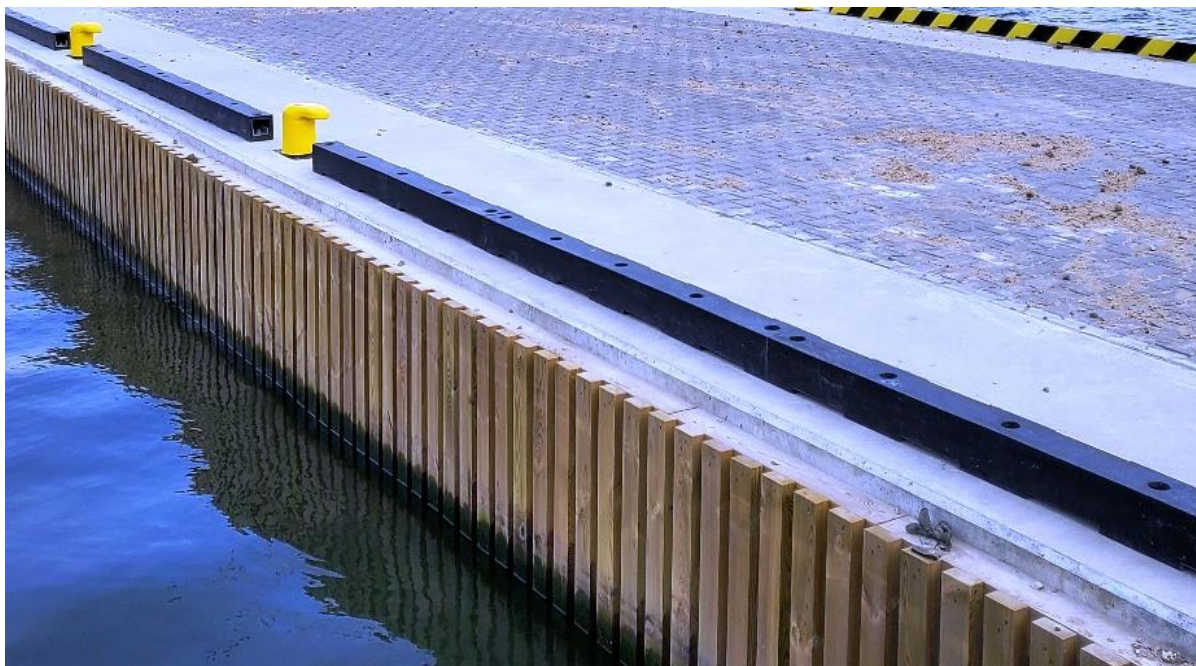
Fot.33. Rama odbojowa z opierzeniem drewnianym; źródło: archiwum własne
