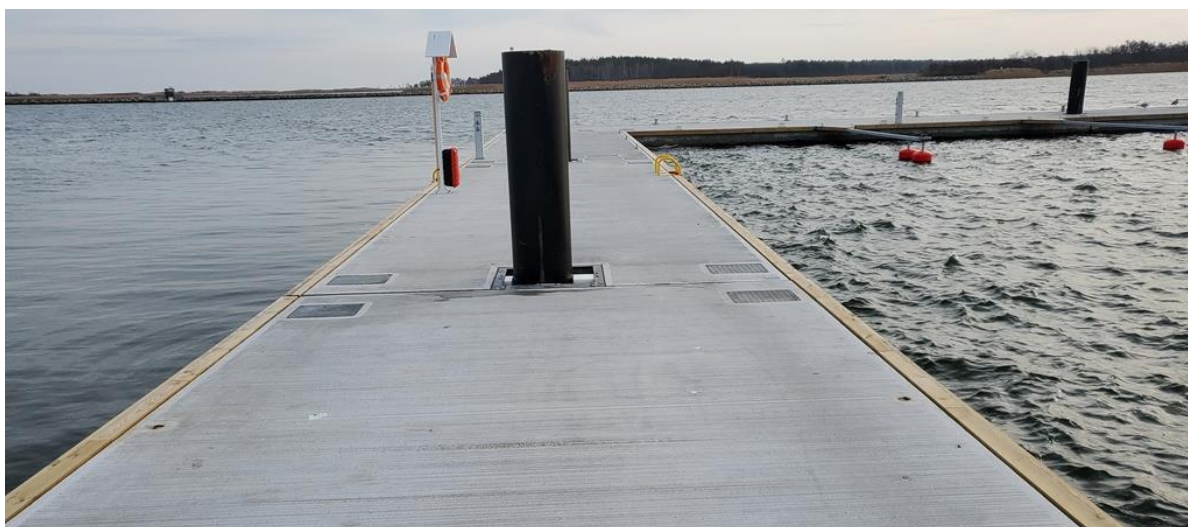
Fot.20. Pomost pływający zakotwiczony do pali stalowych w osi pomostu; źródło: archiwum własne
