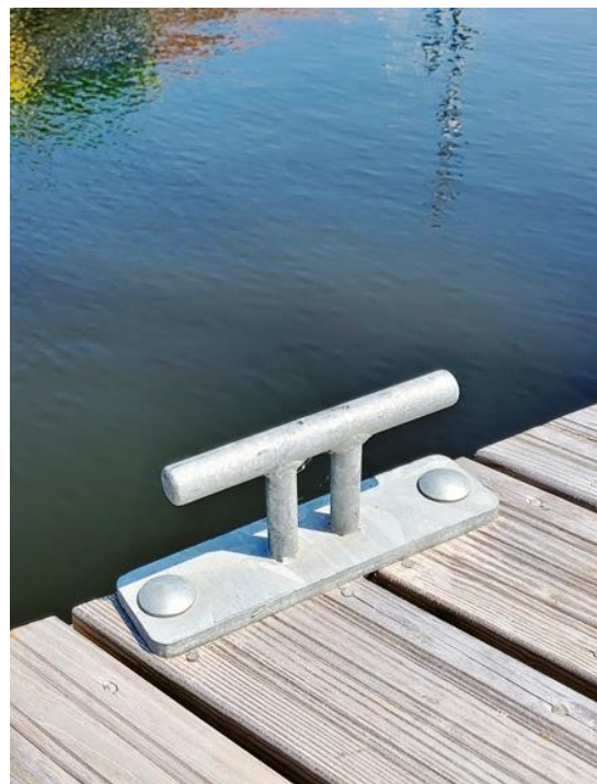
Fot. 31. Pachoł cumowniczy o nośności 157 kN;
