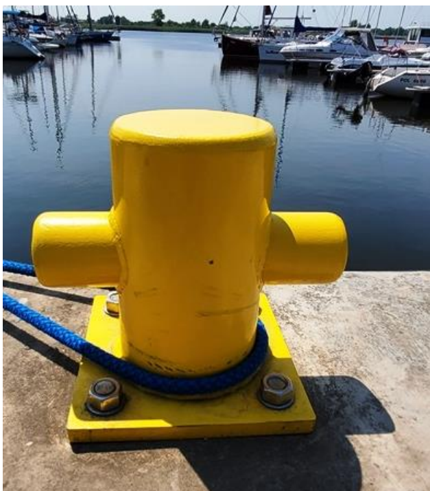
Fot. 31. Pachoł cumowniczy o nośności 157 kN;
