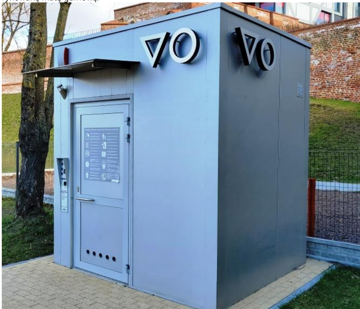
Fot.69. Kontenerowa, bezobsługowa toaleta; źródło: archiwum własne
