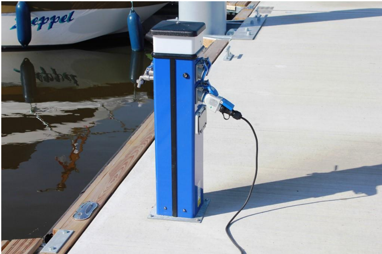
Fot.37. Postument oświetleniowo – zasilający; źródło: archiwum własne
