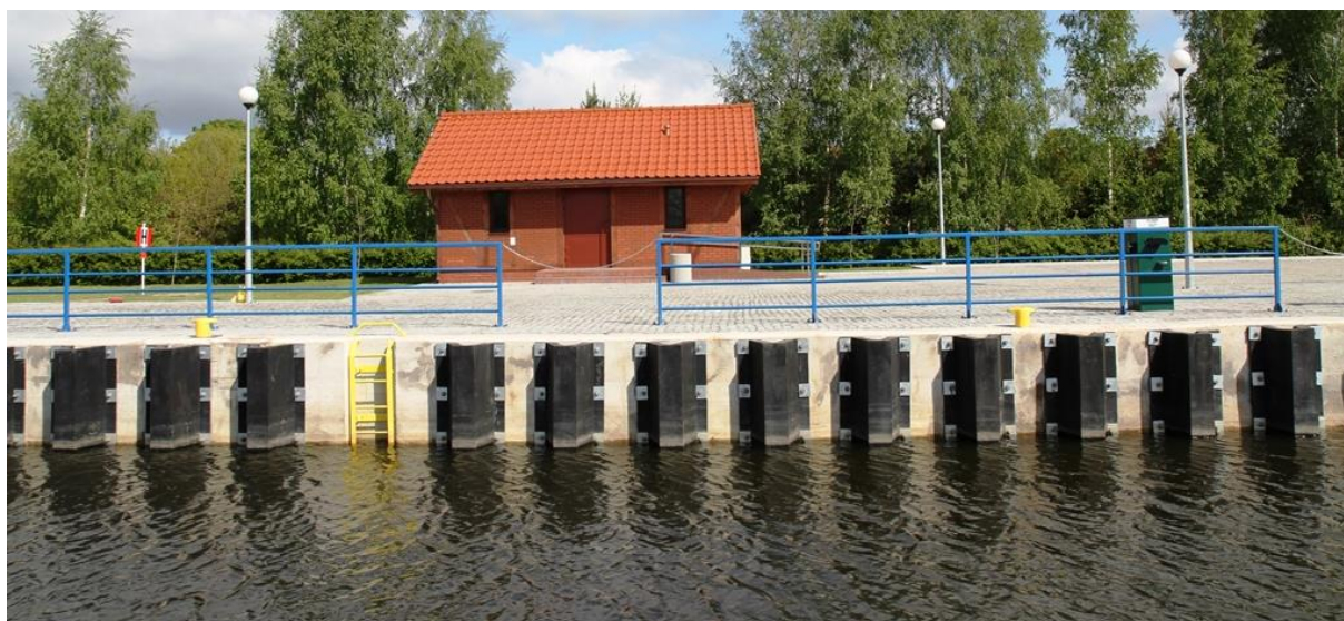
Fot.6. Nabrzeże przystani pasażersko - żeglarskiej o konstrukcji oczepu; źródło: archiwum własne
