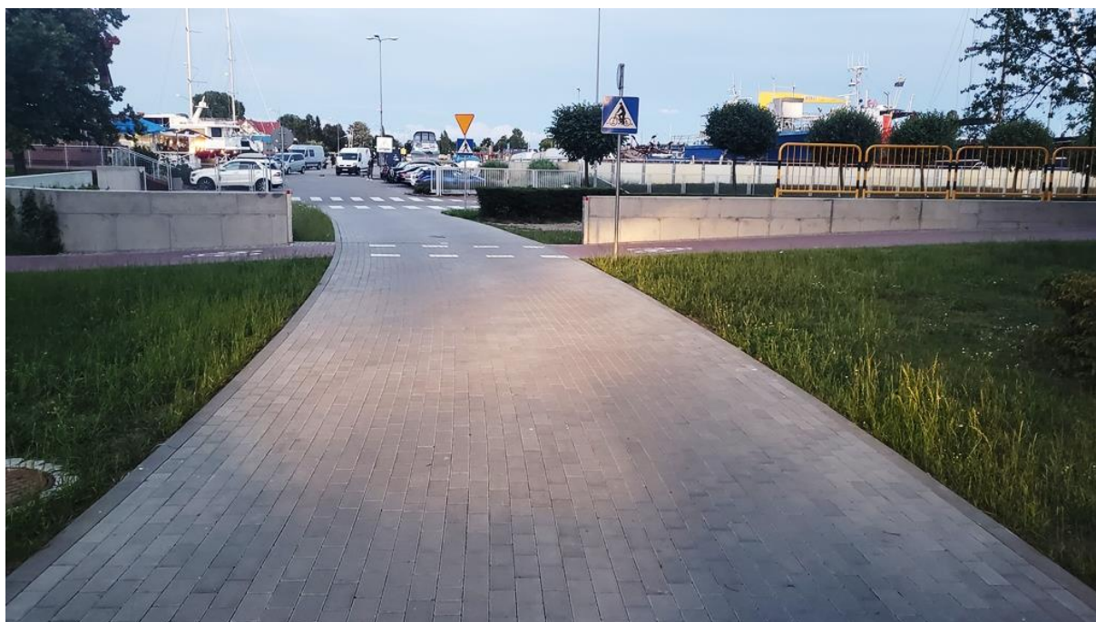
Fot.52. Droga dojazdowa; źródło: archiwum własne
