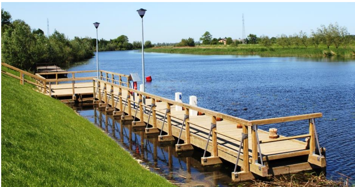
Fot.10. Pomost stały o konstrukcji drewnianej; źródło: archiwum własne
