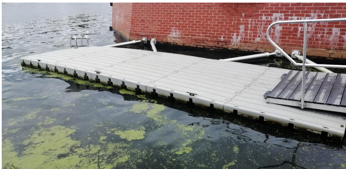
Fot.13. Pomost pływający wykonany z pływaków z tworzyw sztucznych; źródło: archiwum własne
