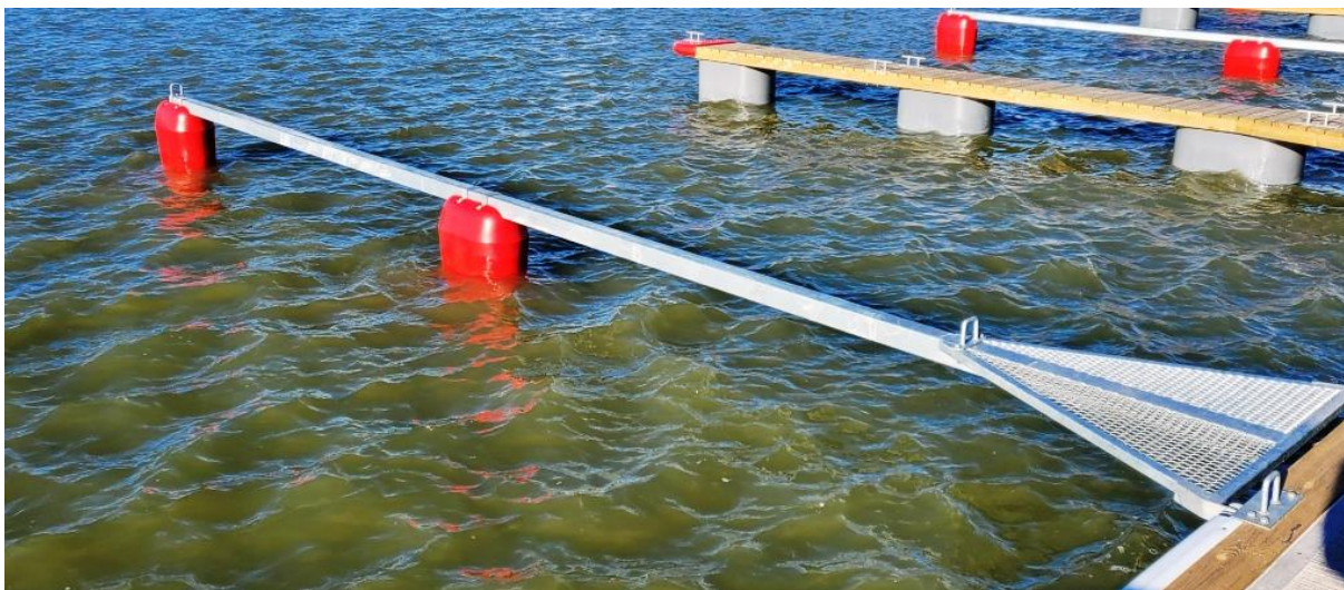
Fot. 17. Wysiężniki z profili stalowych z pływakami z tworzyw sztucznych (y-boomy) bez kładki; źródło: archiwum własne
